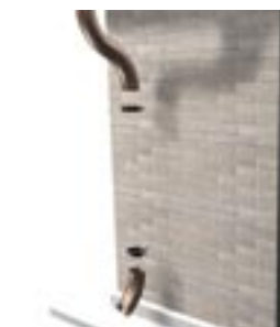
Rozplanowanie obejm rury spustowej
